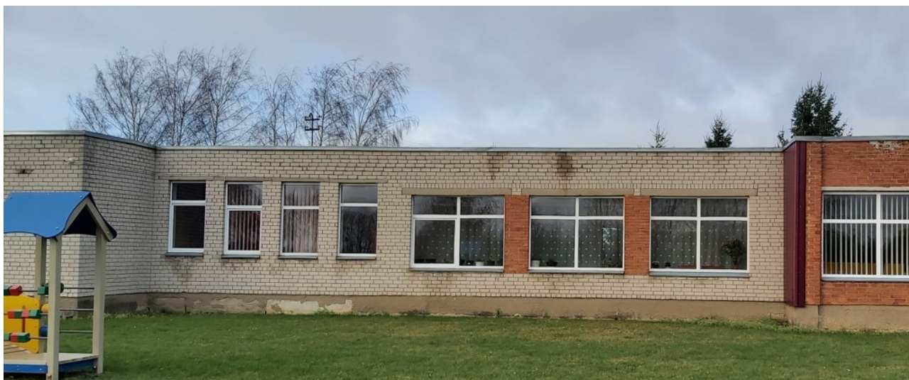
1 pav. Remontuojamo pastato fotofiksacija (2020-11 mėn.).
