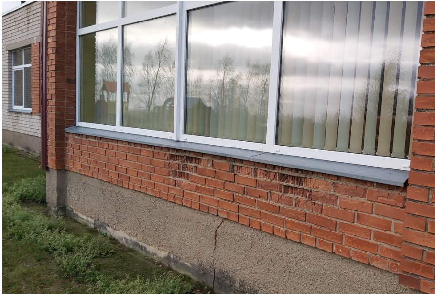
6 pav. Remontuojamo pastato fotografacija (2020-11 mėn.).
