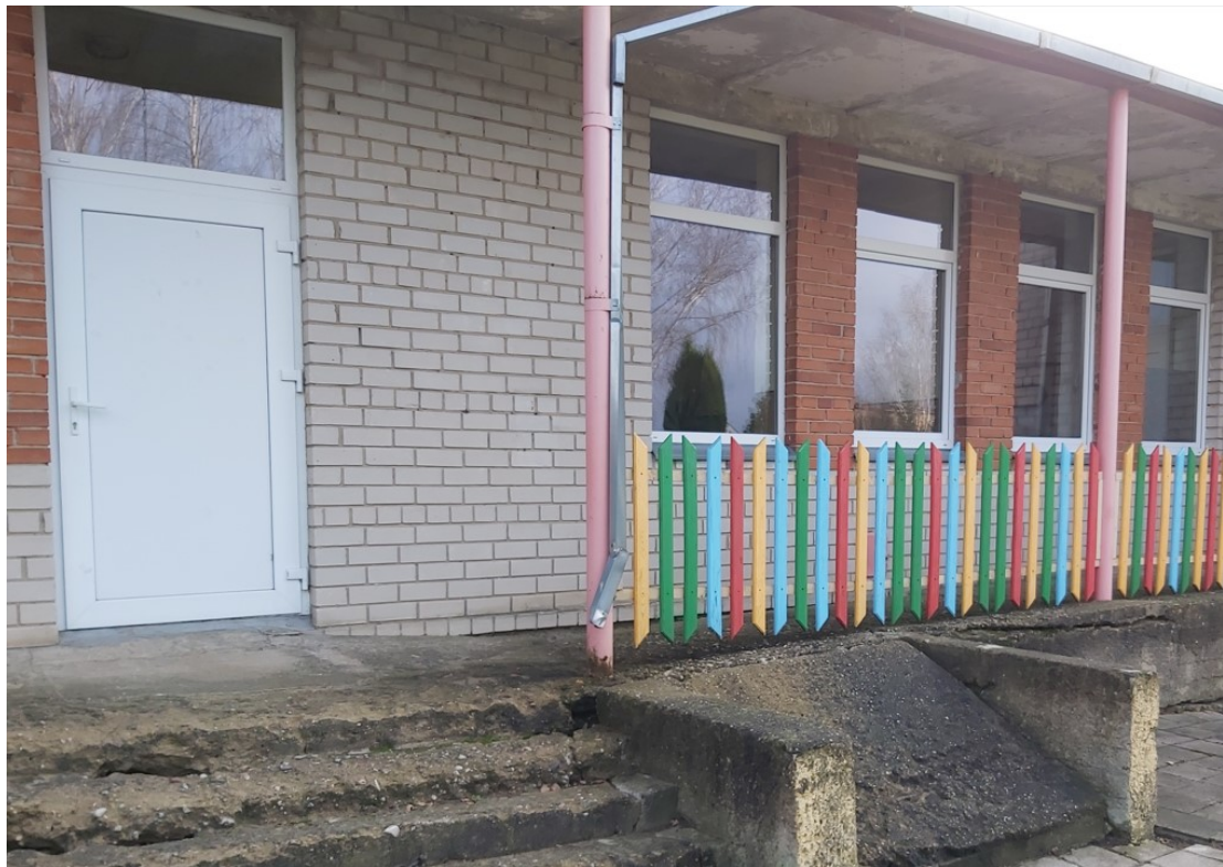
4 pav. Remontuojamo pastato fotografacija (2020-11 mėn.).
