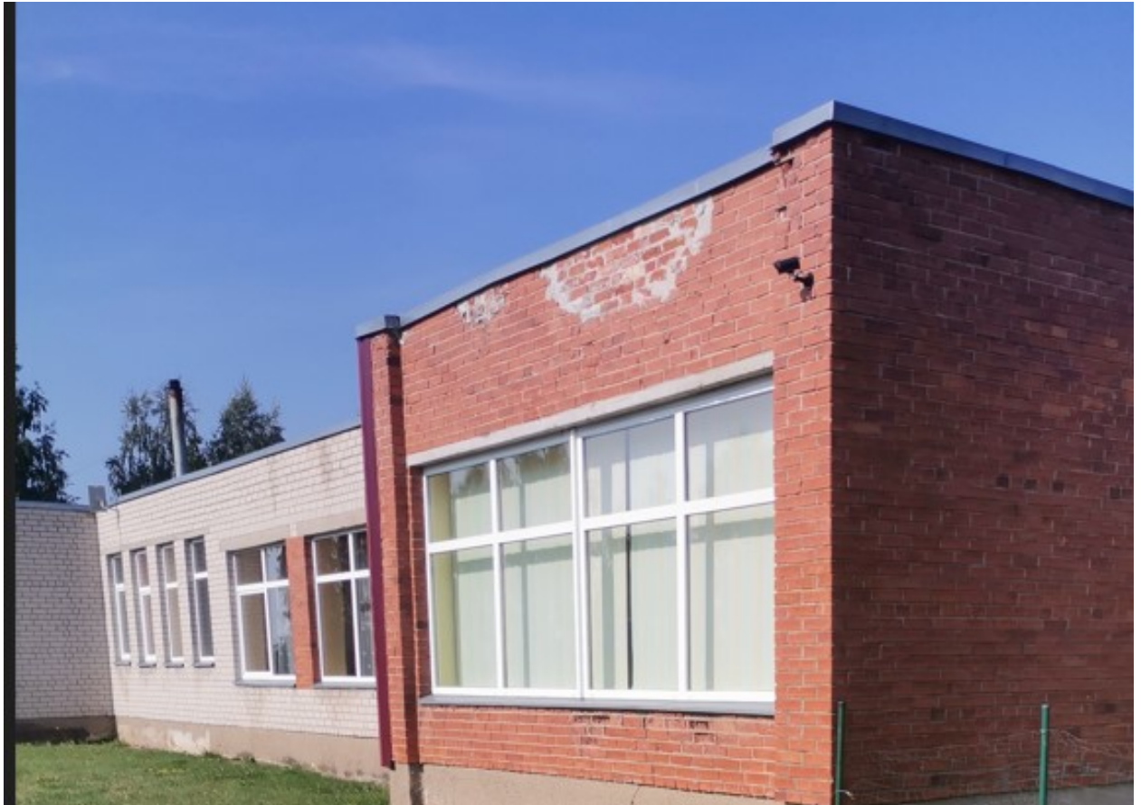
3 pav. Remontuojamo pastato fotofiksacija (2023-08 mėn.).
