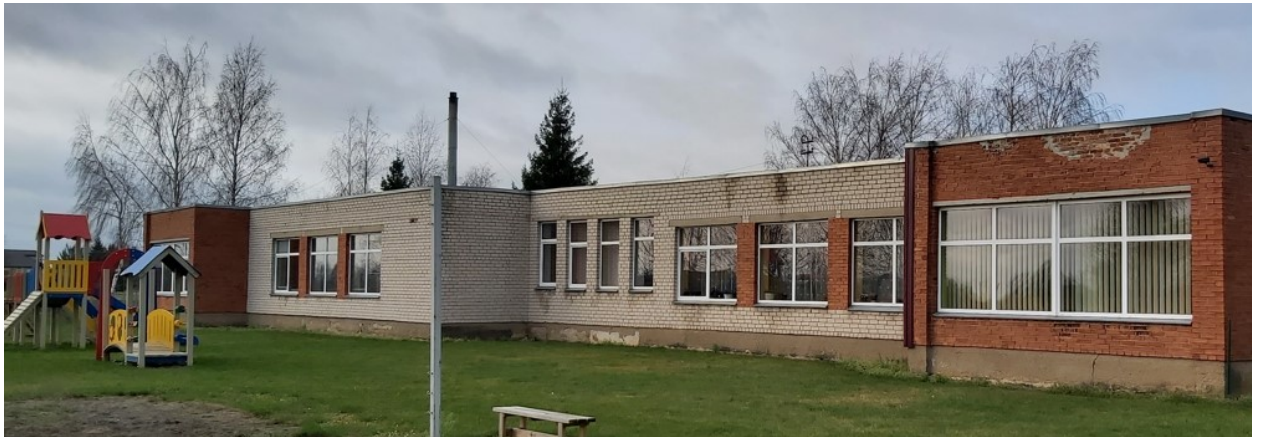
2 pav. Remontuojamo pastato fotofiksacija (2020-11 mėn.).
