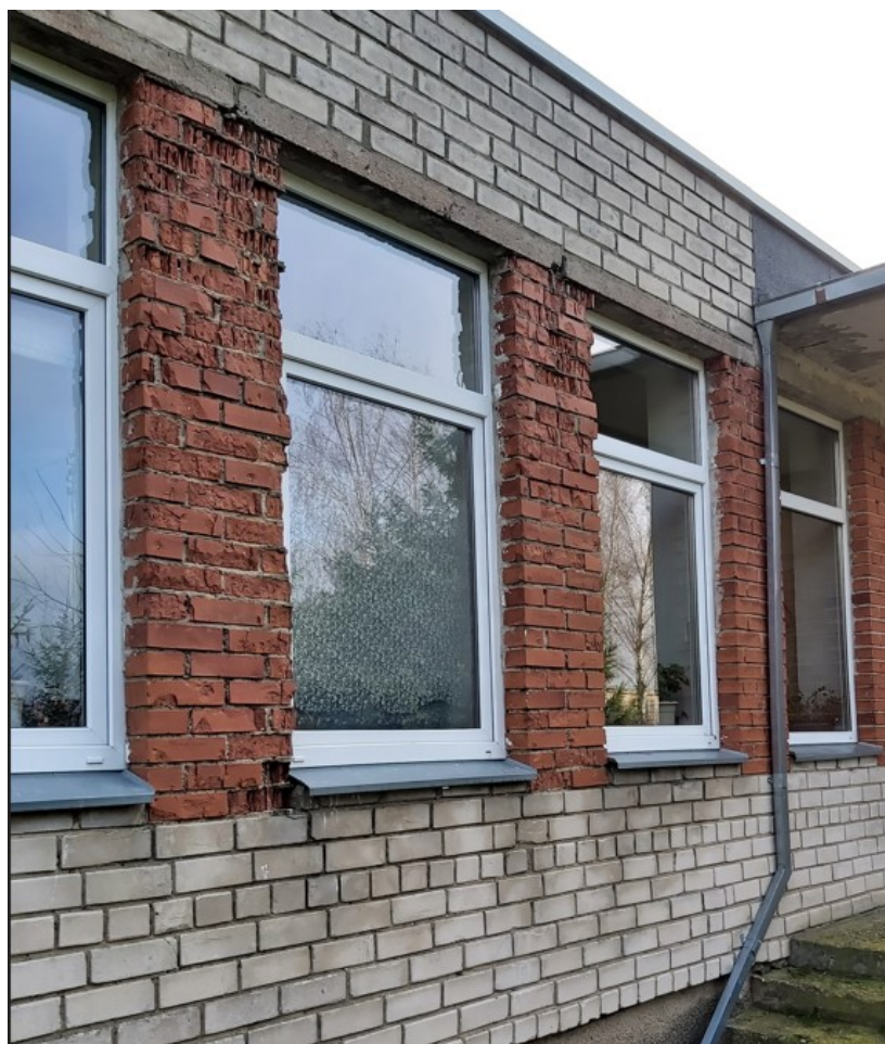
5 pav. Remontuojamo pastato fotografacija (2020-11 mėn.).
